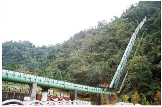
2號倒虹吸管屬新社區中和里。設置在第5號隧道出口與第5號開渠之間，橫貫抽藤坑溪的設備。水平距離289.00公尺，總長346.88公尺，倒虹吸管入口與出口之落差為2.97公尺。為遠東地區最大的倒虹吸工。
