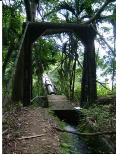
矮山支線過水吊橋位於新社區慶西里。白冷圳在慶西里山豬湖6號隧道上口分出矮山支線，灌溉慶西里一帶。白冷圳過水吊橋為懸索吊橋，主要承載管徑400mm之通水管，屬灌溉用之水利工程。
