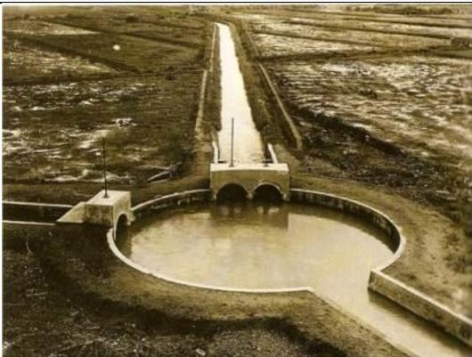
圓堀是白冷圳的分水設施，亦為白冷圳幹線終點。白冷圳有幾處分水設施，圓堀是1號分水池，小圓堀是2號分水池，以分水門將圳水引進分水箱內，居民再從分水箱下方分水閘接續引灌。白冷圳幹線到達圓堀前，分出矮山支線、水底寮支線，灌溉慶西里及東興里一帶。圓堀設有水門，分出馬力埔支線、大南支線及烏銃頭支線等。
