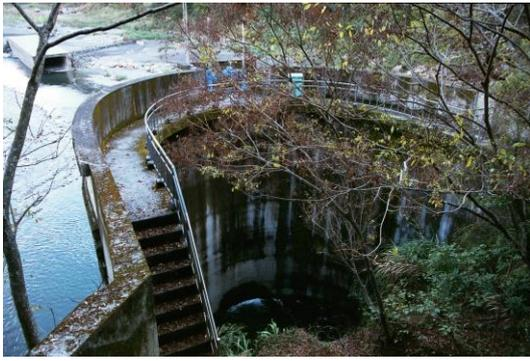
位於和平區天輪里，白冷圳取水入水口，為將大甲溪水引取至白冷圳水路之設施。將水引入進水口，從引水隧道經過制水井，再將水送到第1號隧道。
