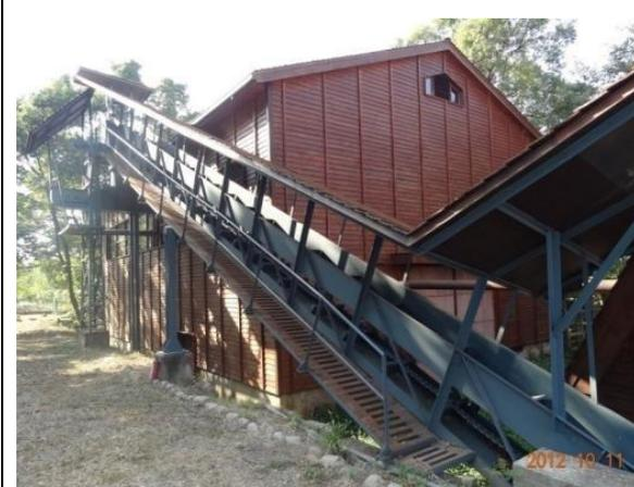
鍋爐間-利用燃料倉提供之廢木料，製造蒸氣發電，作為製材工廠動力之一。
