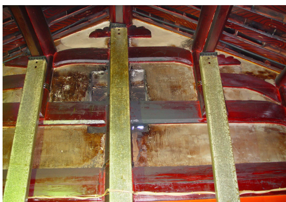
照片 3-8 正殿次間為中柱落地穿斗式構架
