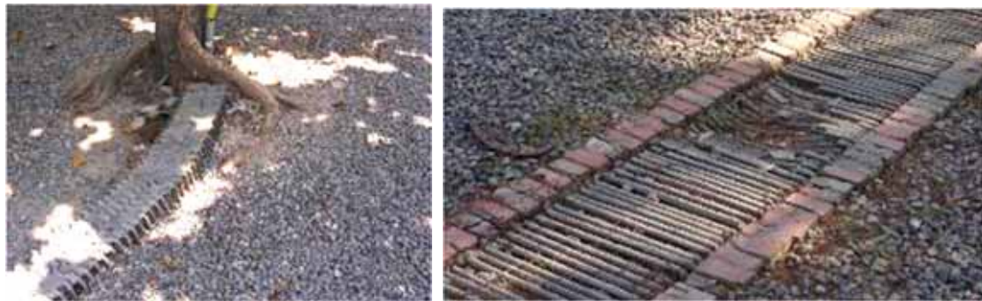
圖 8-3.17 臺南縣歷史建築新東國小校長宿舍廢棄水泥瓦片使用於鋪面
