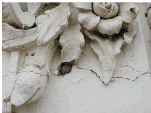
照片 3-3-2 921 集集地震後東側山牆泥塑開裂之情形[3]
