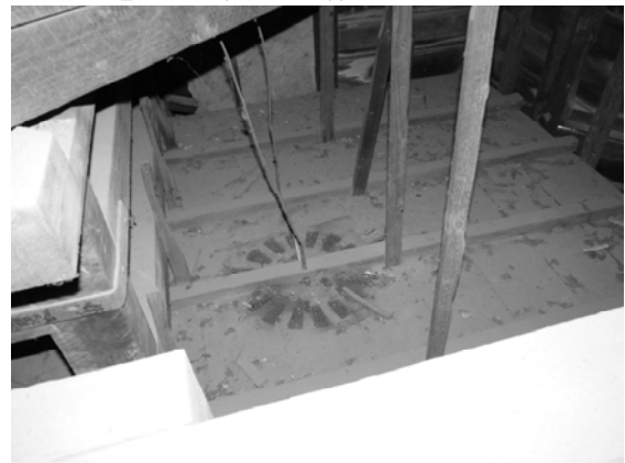
【圖 3-4-144】天花板燈具線路。
