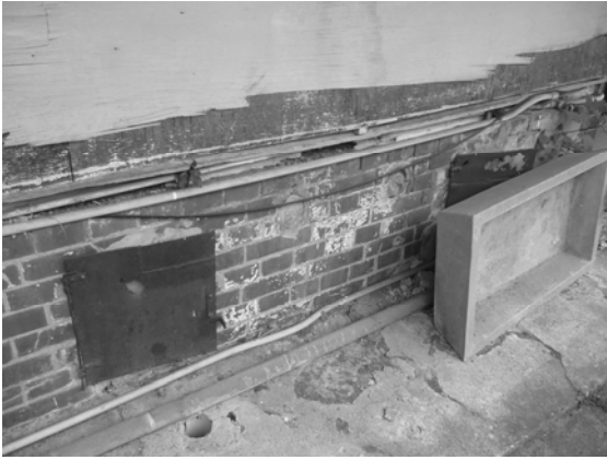
【圖 3-4-145】廁所外挑水肥的開口部及排除沼氣之排氣管遺構。
