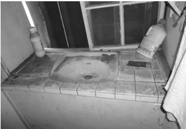
【圖 3-4-147】廁所旁的洗手槽
