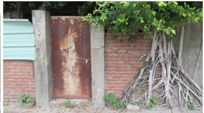
【圖 5-2- 3】大門鐵銹斑駁榕樹氣根直接盤據磚牆
