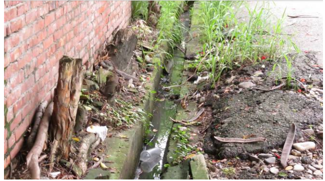
【圖 5-2- 7】側面圍牆外的明溝
