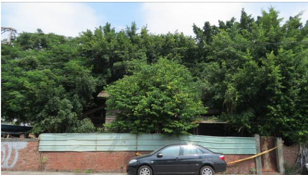
【圖 5-2- 2】榕樹幾乎已完全包被建築物正立面
