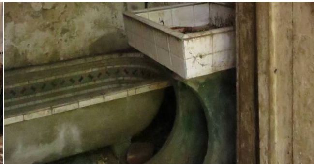
【圖 5-2- 11】側院增建的衛浴空間
