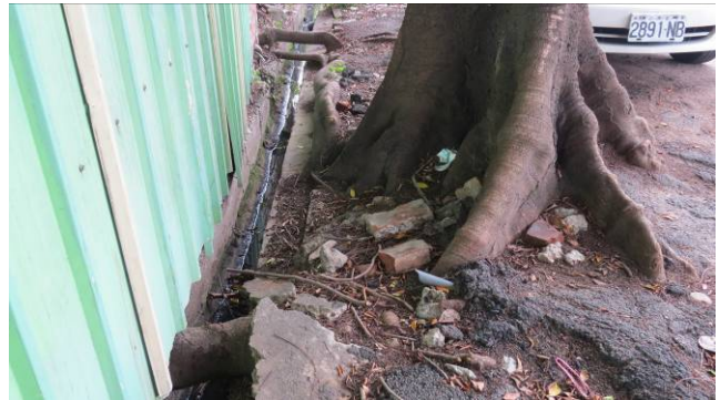
【圖 5-2- 9】鳳凰木根系直接穿越水溝進入基地
