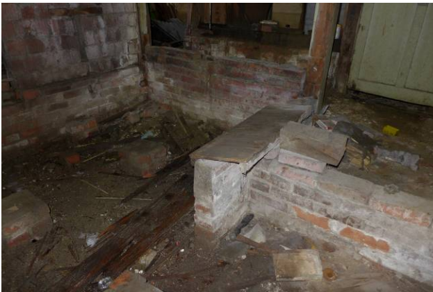
【圖 5-1- 26】地面垂直向的磚牆應為前期所遺留的外牆牆基。
