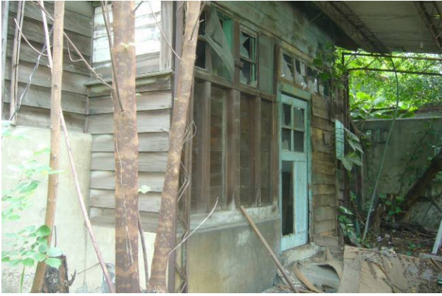
【圖 5-1- 24】入口及側邊的便所外觀。
