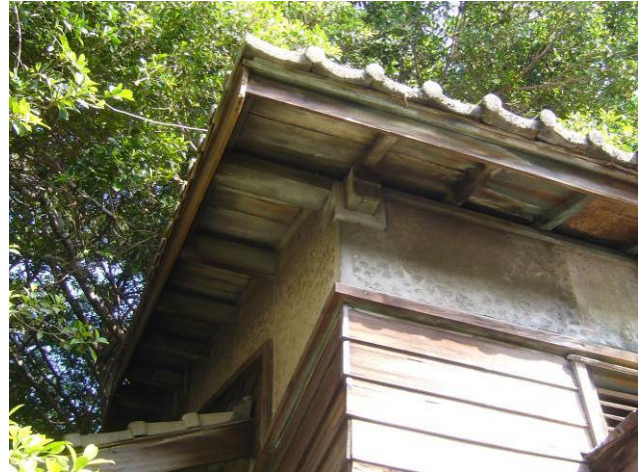
【圖 5-1- 35】浴場洋式風格的拉毛灰泥施作。
