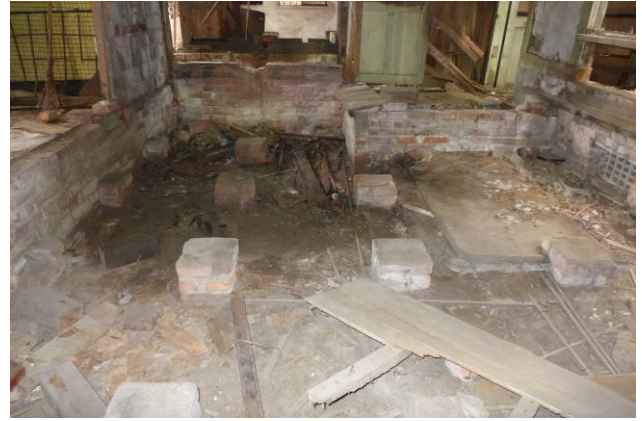
【圖 5-1- 25】脫衣場為架床式構造。
