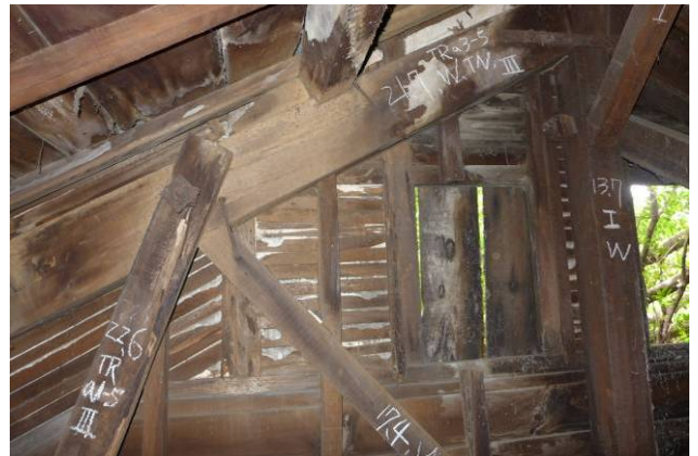
【圖 5-1- 39】浴場山牆的木摺板壁。
