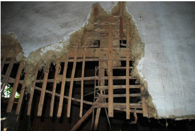
【圖 5-1- 38】脫衣場的真壁隔間牆。
