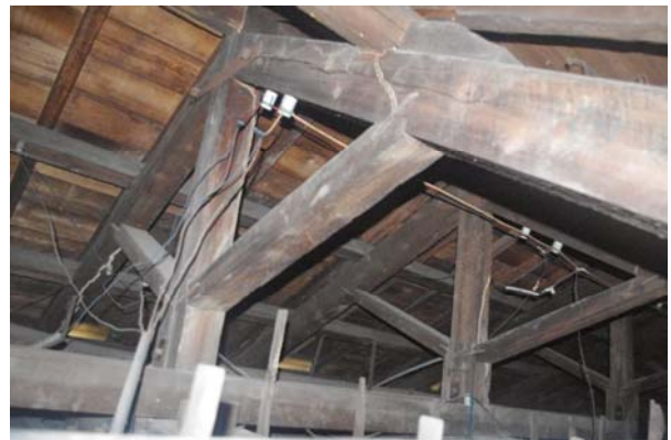
【圖 4-2-8】臺中刑務所典獄官舍之正同柱式木屋架
