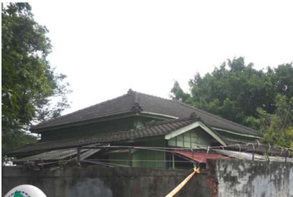
【圖 4-2-7】臺中刑務所典獄官舍之寄棟造屋頂
