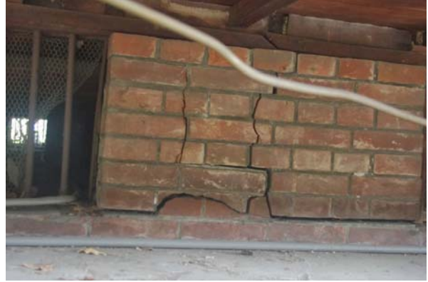
【圖 4-2-25】磚造基牆水平及垂直裂縫 (和館)
