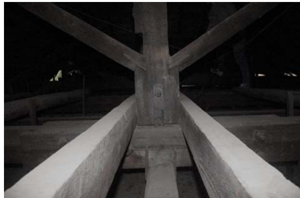
【圖 4-2-13】屋架間之縱向水平夾撐
