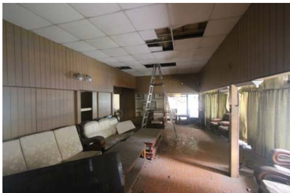
【圖 4-2-28】後期室內壁面裝修
