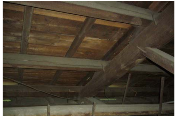
【圖 4-2-37】桁條之乾縮裂縫
