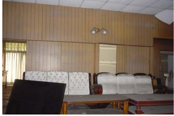
【圖 4-2-5】臺中刑務所典獄官舍之室內壁面裝修
