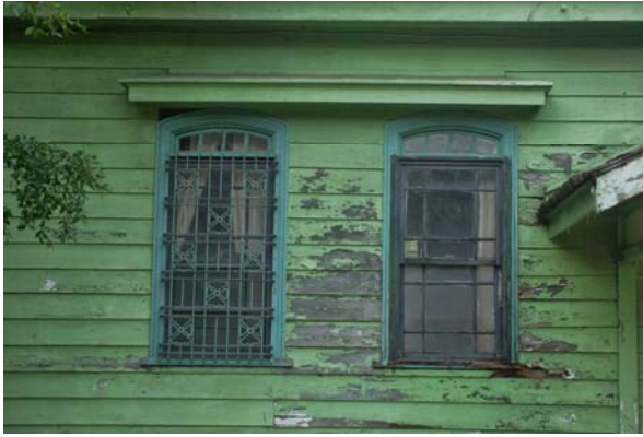
【圖 4-2-16】牆體外側採雨淋板構法
