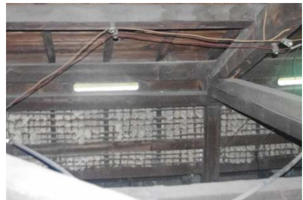
【圖 4-2-15】編竹夾泥牆內部構造
