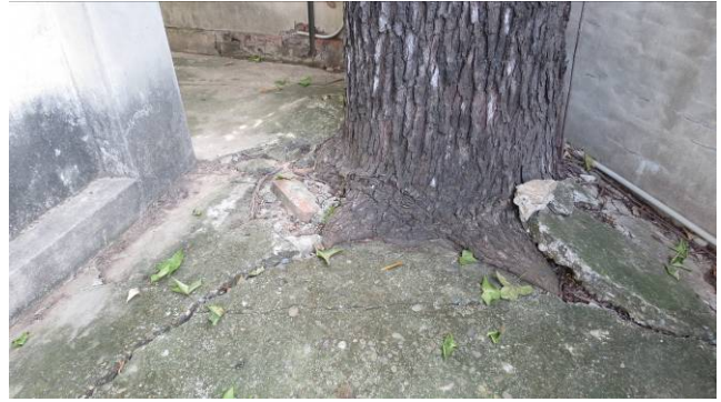
【圖 3-3- 46】水泥鋪面限制楓香根系生長
