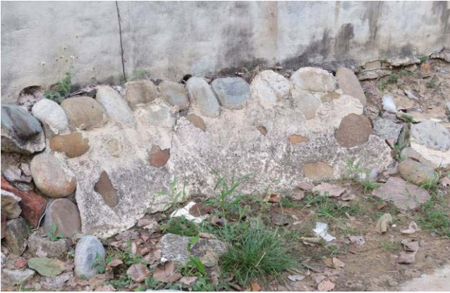
【圖 3-3- 20】官舍貴和街圍牆外仍可見原水池殘跡
