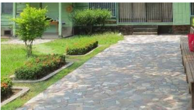
【圖 3-3- 8】大門入口主動線由花崗石邊角料鋪設
