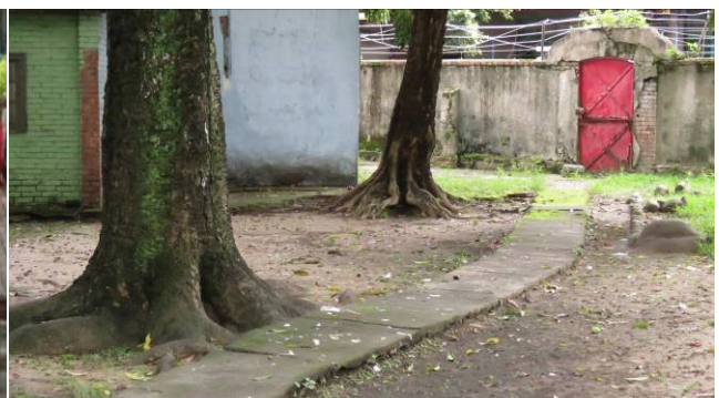
【圖 3-3- 9】側門動線由預鑄水泥板鋪設
