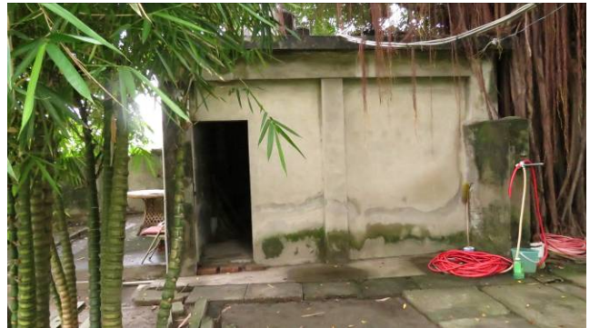
【圖 3-3- 17】車庫背立面鋪設水泥板連接至建築入口
