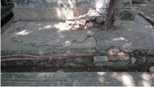
【圖 3-3- 47】榕樹根系及氣根破壞建築物犬走
