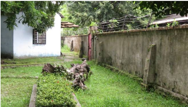
【圖 3-3- 6】自由路一段 89 巷圍牆內扶壁柱
