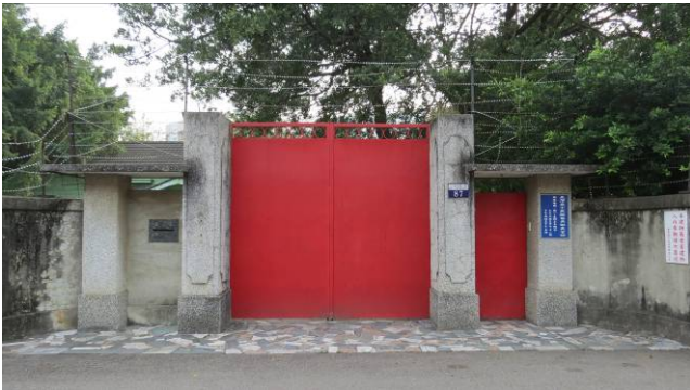
【圖 3-3-2】民國 70 年代修築完成的大門入口
