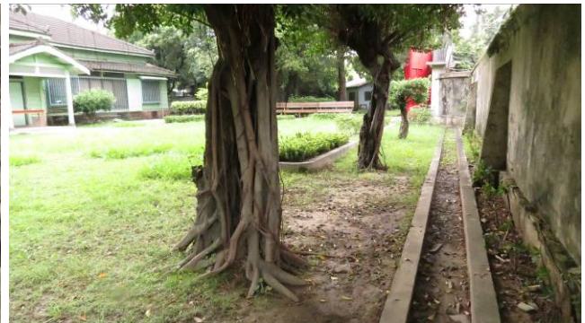
【圖 3-3- 13】右側庭園水溝尺度較寬但淤積無作用
