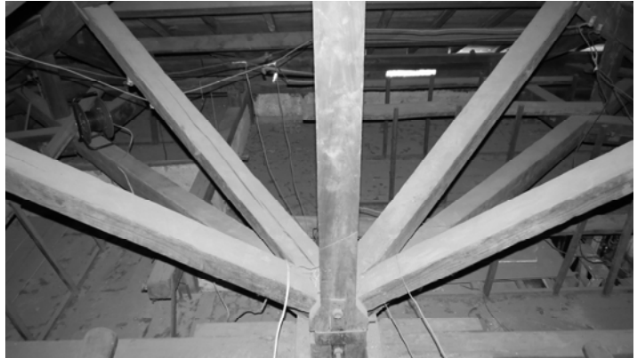
【圖 3-4-66】屋頂斜坡面的放射狀屋架型態。
