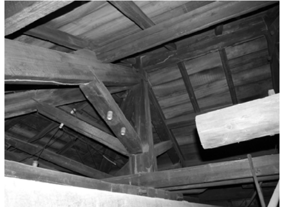
【圖 3-4-71】斜坡面亦為放射狀的屋架。
