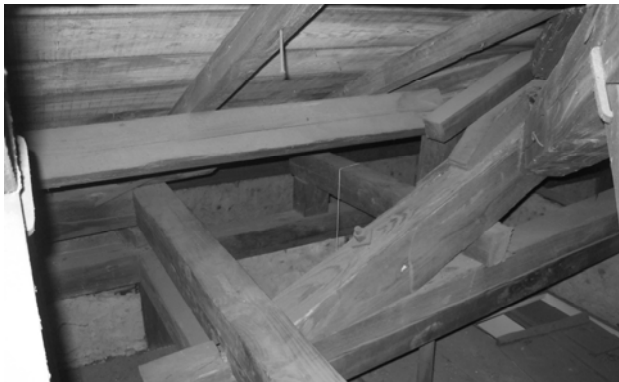
【圖 3-4-79】和館鼻母屋在洋館的交接情形。
