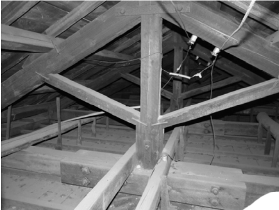
【圖 3-4-70】洋館單組屋架現況。
