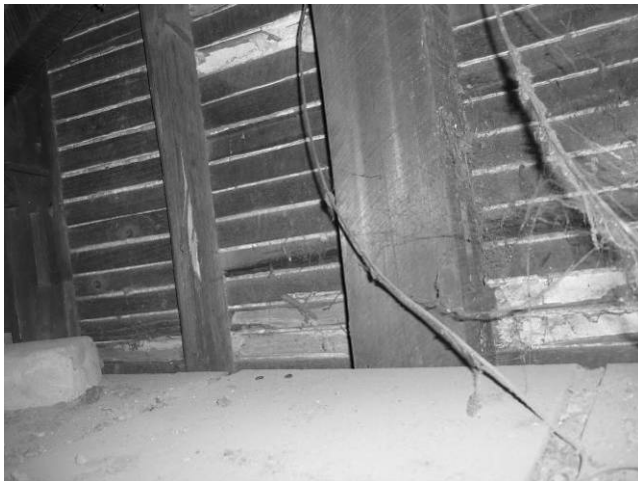
【圖 3-4-58】大壁的室內牆面以木摺板釘出骨架
