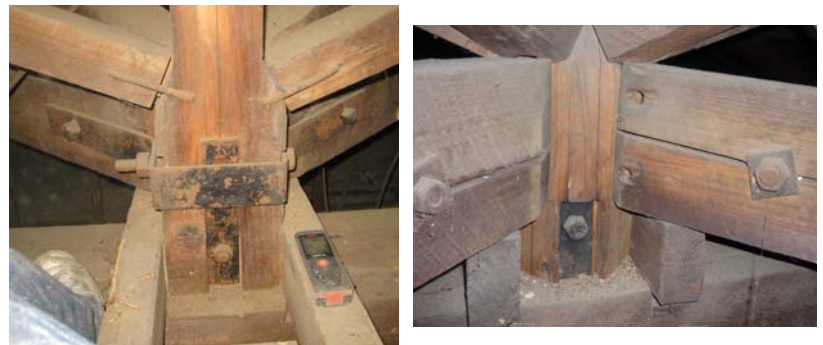
【圖 3-4-89】中柱與斜向方仗以五金構件連結情形
