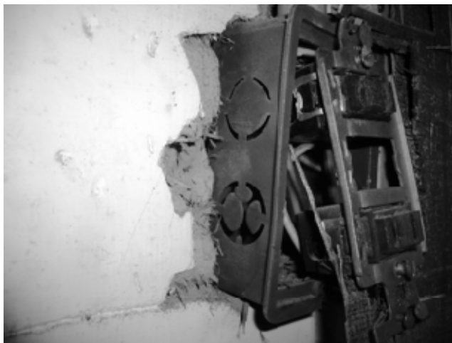
【圖 3-4-51】室內牆面表面具白灰粉刷層
