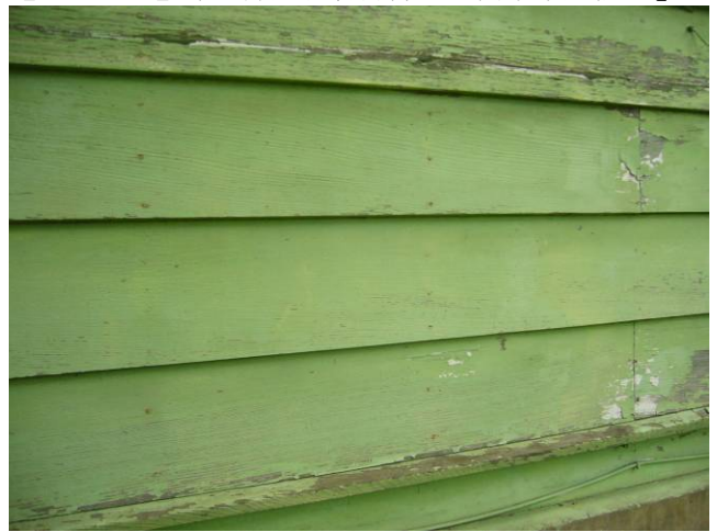
【圖 3-4-57】每片板材上釘痕外露 3 根，左右等距排列
