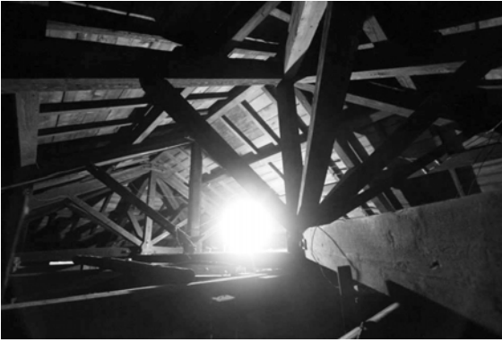
【圖 3-4-63】和館三組中柱式屋架。
