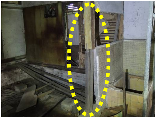
【圖 6-1-20】女浴場前側立柱(編號 X9Y4)遭鋸斷。
