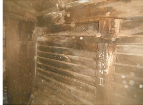
【圖 6-1-14】太子樓的短柱遭白蟻危害
