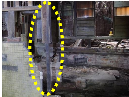
【圖 6-1-21】女浴場後側立柱(編號 X11Y4)遭鋸斷。
