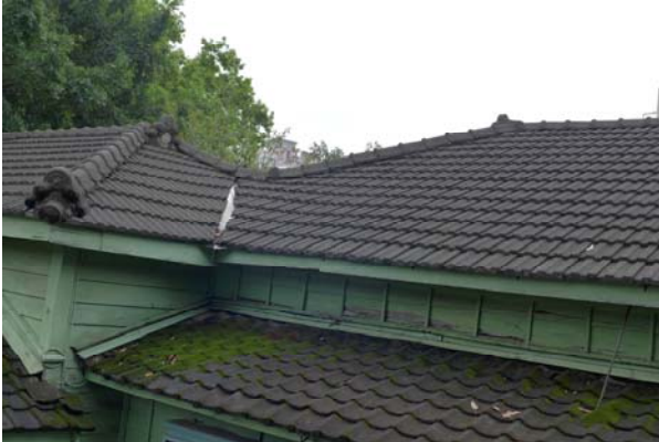
【圖 3-4-123】正立面洋館與和館屋頂搭接處與洩水處
