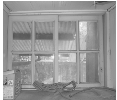
【圖 3-4-140】位於廁所旁押入的通氣窗
