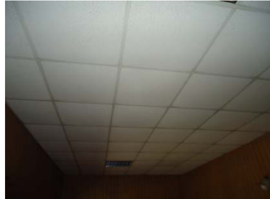
【圖 3-4-120】和館廣間與居間的天花板鋪設輕鋼架系統天花板
