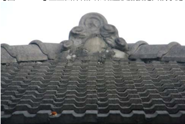
【圖 3-4-125】鋪設於洋館與和館屋頂上之水泥瓦。
