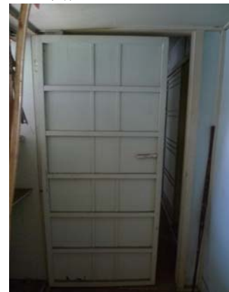
【圖 3-4-135】押入的木製拼組門，淺綠色油漆為後期增加塗色
