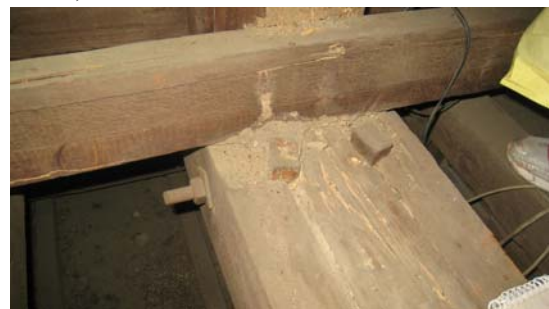
【圖 3-4-92】水平大料「添板繼」的卡樑細節。
