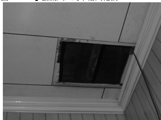
【圖 3-4-118】洋館的天花板以貼滿新的夾板。
