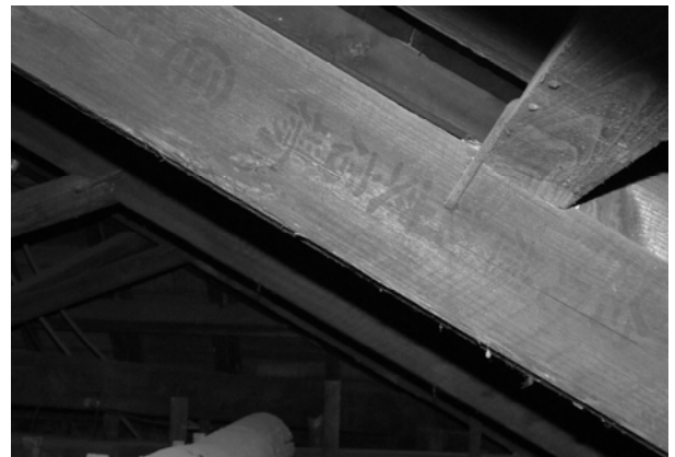
【圖 3-4-103】洋館的屋架木料亦有「臺北植松支店場⊙出」的墨字。
