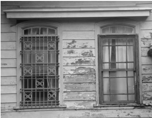
【圖 3-4-138】位於洋館的應接室的對外窗，為洋式風格上下推拉窗
