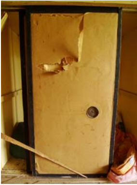
【圖 3-4-136】和館原有的左右推拉襖門，上鋪有後來的油紙或牛皮紙
