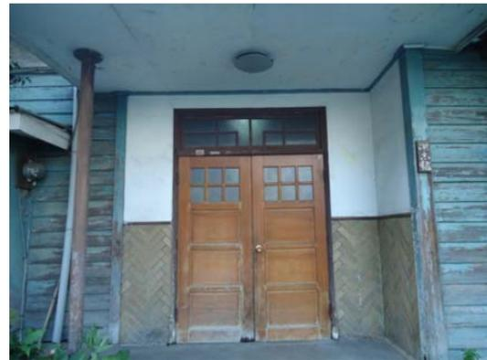
【圖 3-1-4】大門立面樣式為洋式風格，磁磚拼貼精緻典雅。雨淋板為英國雨淋板。
