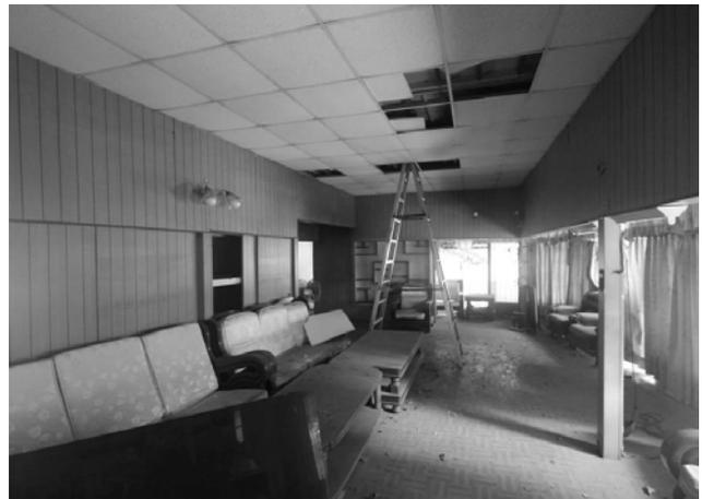
【圖 3-2-8】現在的室內一景，後來的天花板鋪設上輕鋼架系統天花板，地板貼皮爲木紋塑膠地板。
