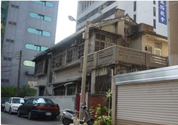
【圖 3-1- 13】鋼筋混凝土造建物立面，二樓露台欄杆洗石子裝飾細膩典雅。
