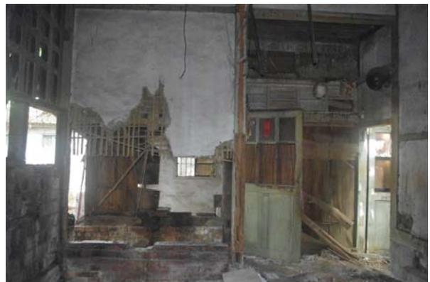
【圖 6-2-30】隔間牆壁體損壞嚴重
