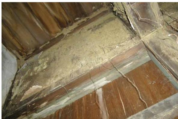
【圖 6-2-36】植物氣根侵入造成牆體劣化
