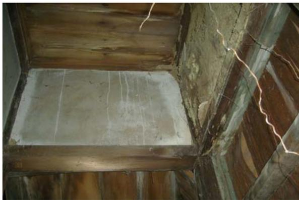
【圖 6-2-31】屋頂漏水嚴重、土壁劣化流失
