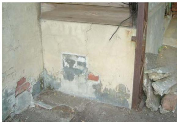
【圖 6-2-26】磚造基牆保護層劣化、剝落
