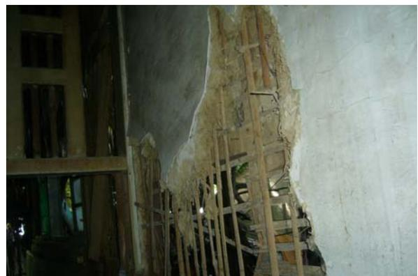
【圖 6-2-21】編竹夾泥牆內部構造
