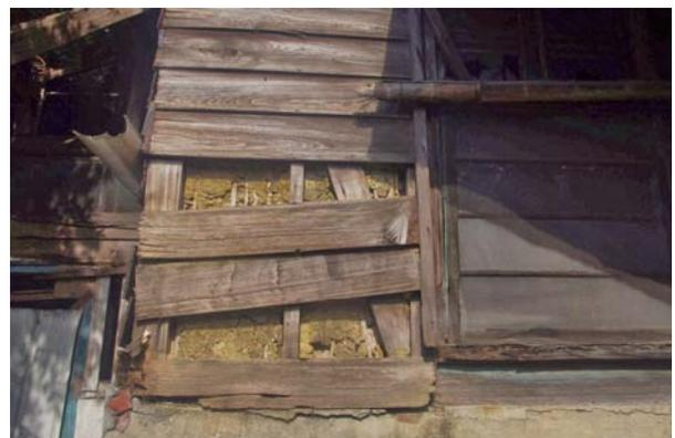
【圖 6-2-22】外牆壁體內部設置木斜撐
