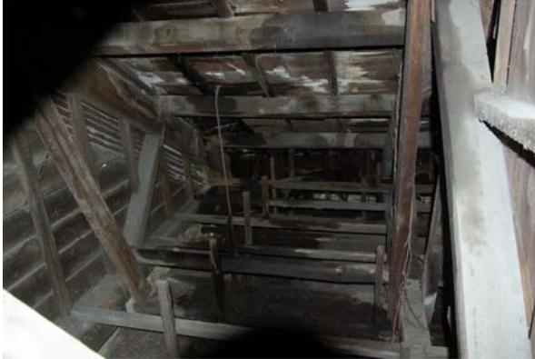
【圖 6-2-38】臺中刑務所浴場屋頂破損漏水
