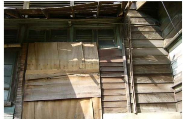
【圖 6-2-20】編竹夾泥牆外覆雨淋板
