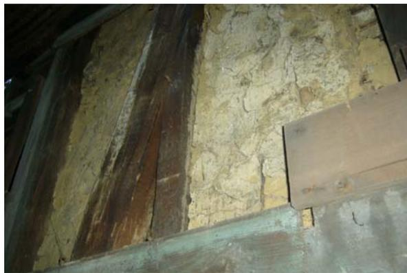
【圖 6-2-32】雨淋板腐朽剝落、土壁外露
