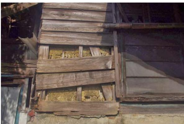
【圖 6-2-33】雨淋板腐朽剝落、土壁外露
