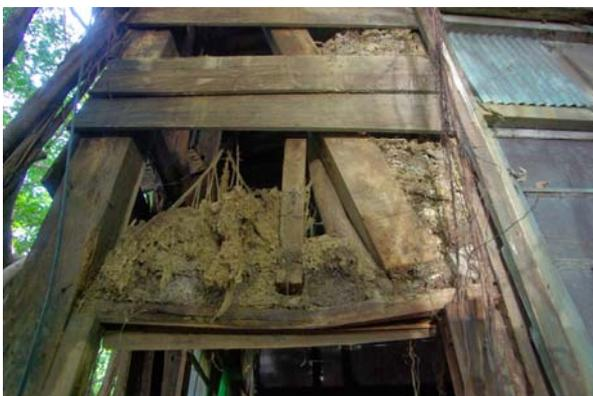
【圖 6-2-35】植物氣根侵入牆體構造
