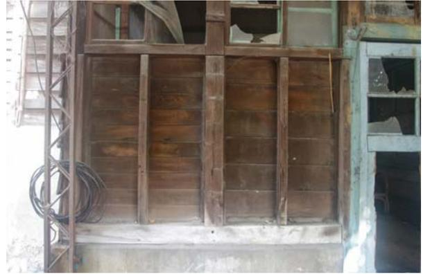
【圖 6-2-18】南側玄關外牆採框組式構造
