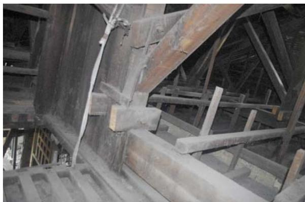
【圖 6-2-15】屋架之水平夾撐已遭受切除
