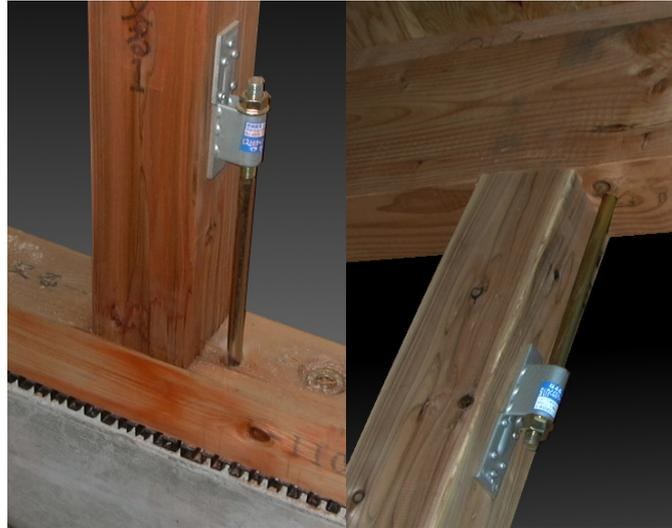
【圖 6-2-58】第 I 型接合鐵件補強（日本建設省告示 1460 號）
