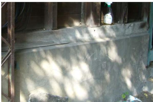
【圖 6-2-25】磚造基牆保護層龜裂
