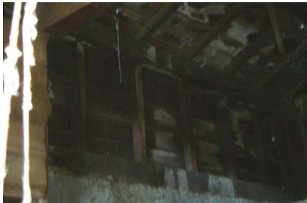
【圖 6-2-19】西側空間外牆採雨淋板構造
