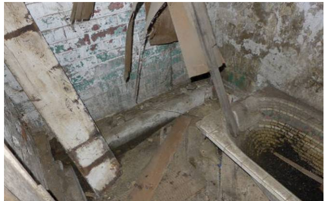
【圖 5-3-123】鍋爐室內牆邊槽狀水泥，可能是排水道
