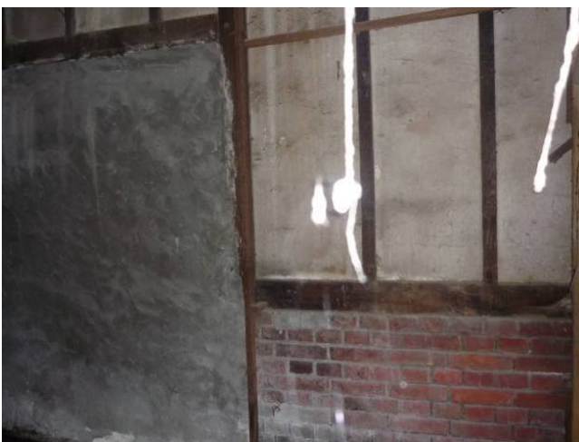
【圖 5-3-38】鍋爐場與浴室隔間牆清水面紅磚砌，屬英式砌法
