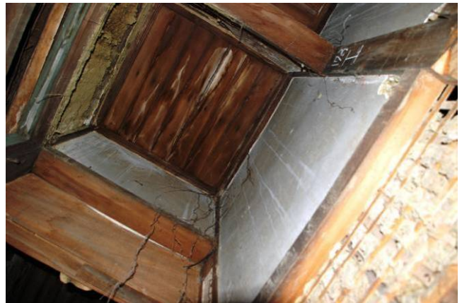
【圖 5-3-80】便所間的天花板
