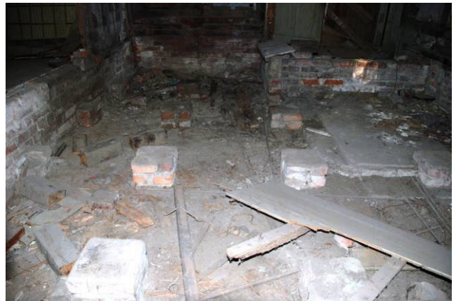
【圖 5-3-6】女更衣室架床構造的底部為水泥沙漿粉光
