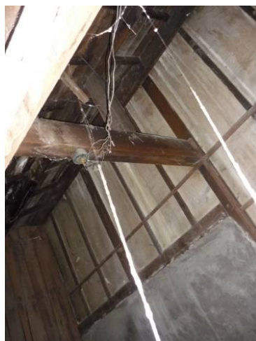
【圖 5-3-39】鍋爐場與浴室隔間牆構造
