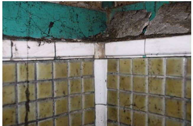
【圖 5-3-92】轉角及轉化材料的收頭採用各式白色磁磚
