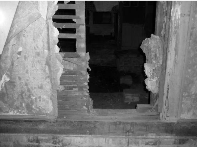
【圖 5-3-26】男女更衣場隔間牆，長押以下為木摺壁
