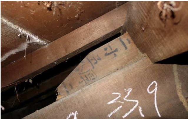
【圖 5-3-59】材料商留下尺寸「二寸五分厚二....」，見位置⑦
