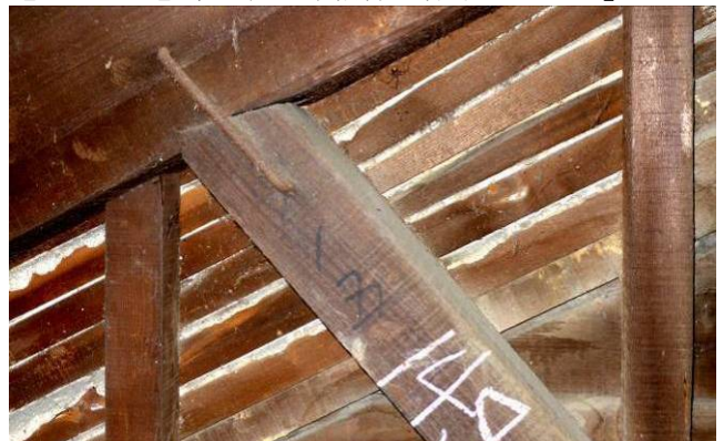
【圖 5-3-52】第五組屋架構件上標示「ソ（？）ノ五」
