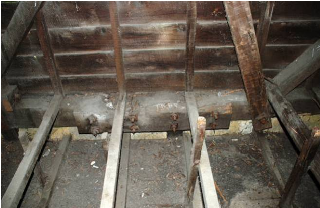
【圖 5-3-63】附壁屋架陸樑採用接合板補強搭接處
