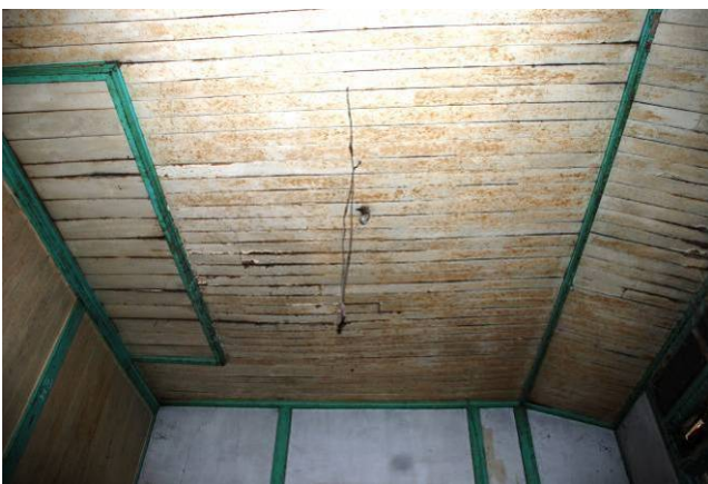
【圖 5-3-75】男浴室的天花板，原太子樓處的鏤空天花設計已封住
