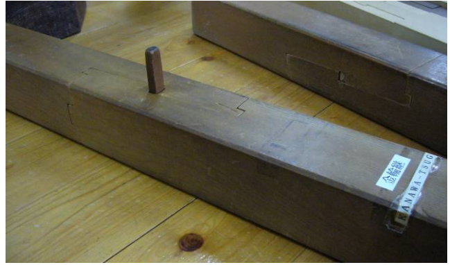
【圖 5-3-69】中間三組屋架採用類似「金輪繼」的榫接法 【圖 5-3-70】「金輪繼」(攝於飛驒古川文化館)
