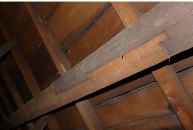
【圖 5-3-67】木桁對接採「追掛込栓繼」
