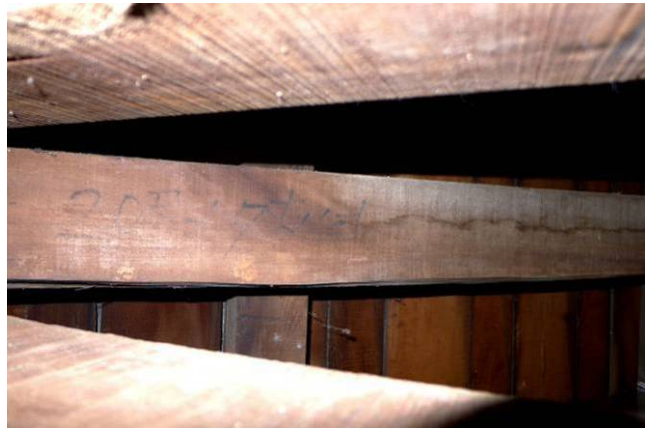
【圖 5-3-56】第三組屋架合掌上有「20尺x7寸x4寸」，與下左圖較似是戰後修繕所標，見位置④
