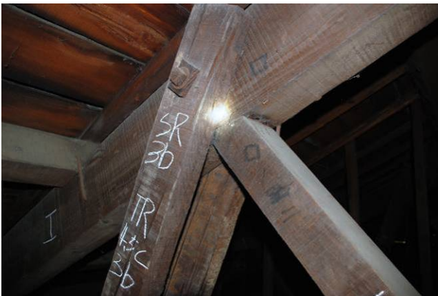
【圖 5-3-49】第二組屋架構件上標示「ロノ二」
