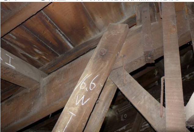
【圖 5-3-65】挾方杖用螺栓、方杖用螞蝗釘固定
