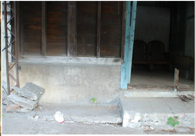
【圖 5-3-25】臺基為紅磚砌水泥粉刷，表面狀況良好
