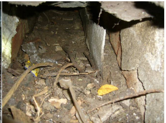
【圖 5-3-4】前方左側的排水溝
