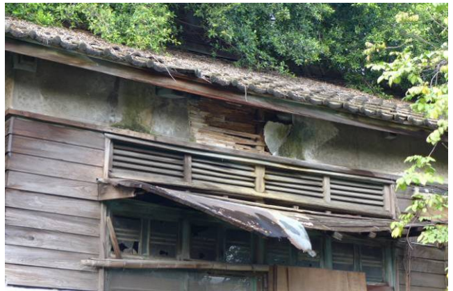
【圖 5-3-109】前後牆窗分三層，除高窗上方還設百葉窗
