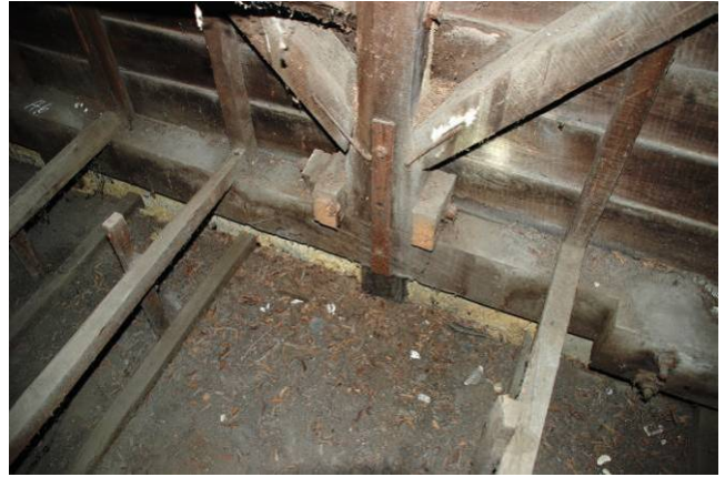
【圖 5-3-62】山牆附壁屋架束與陸樑以箱型鐵固定
