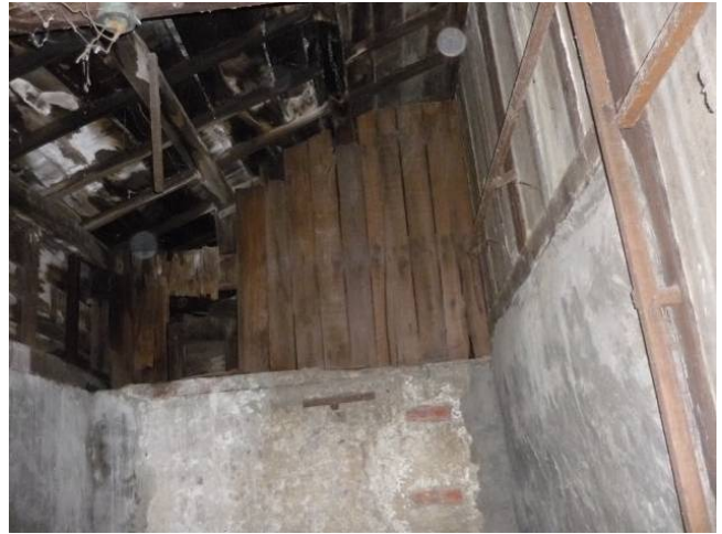
【圖 5-3-41】鍋爐場的室內隔間牆，初判為後期新增
