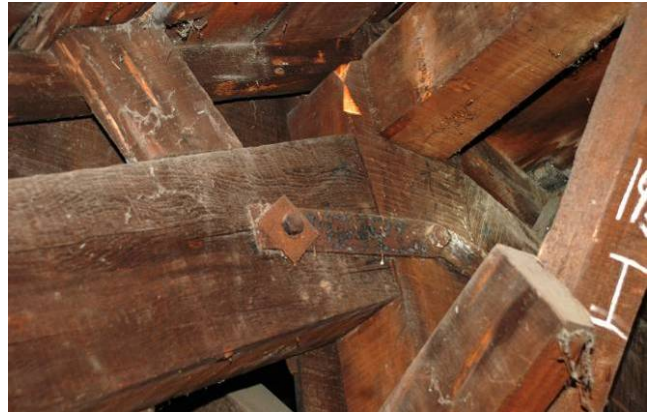
【圖 5-3-64】中間三組屋架合掌與真束以倒 V 鐵件固定
