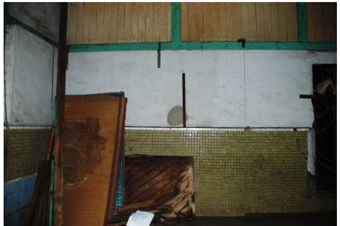
【圖 5-3-35】男女浴場的隔間牆，磁磚、灰泥粉刷、羽目板張，三種表面裝修材
