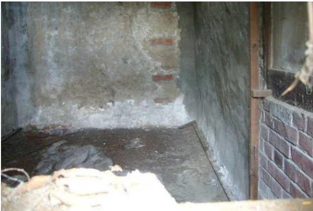
【圖 5-3-7】鍋爐間為土間型式
