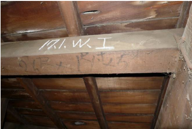
【圖 5-3-57】方桁上有「26尺x1尺1寸x5？」，見位置⑤
