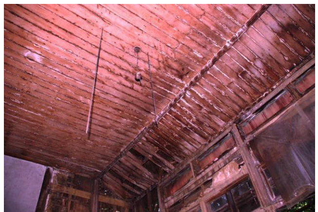
【圖 5-3-76】女浴室的天花板，右側靠牆處順著屋架補強材降下，使空間增加變化
