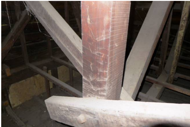
【圖 5-3-71】真束兩側分別留下機具及手工工具的痕跡 【圖 5-3-72】真束兩側的夾枋被鋸斷
