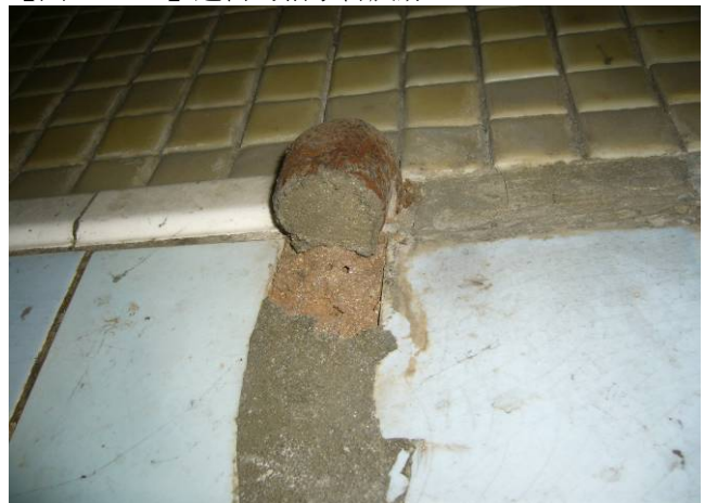
【圖 5-3-121】遺留的給水鐵管頭
