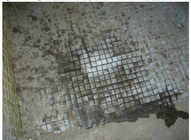
【圖 5-3-10】浴室地面四周牆邊留有淺淺的排水溝槽
