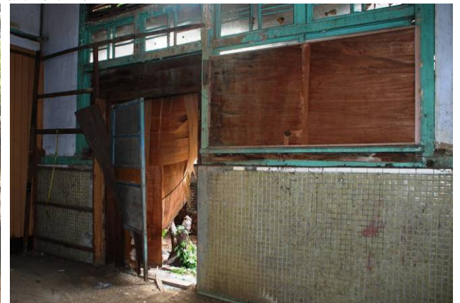
【圖 5-3-33】浴場外牆的室內裝修，紅磚砌部分以磁磚為表面裝修材
