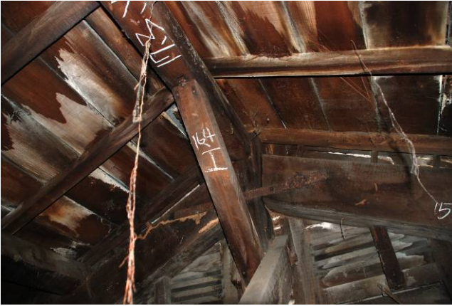
【圖 5-3-61】山牆附壁屋架合掌與束以一字型鐵件固定
