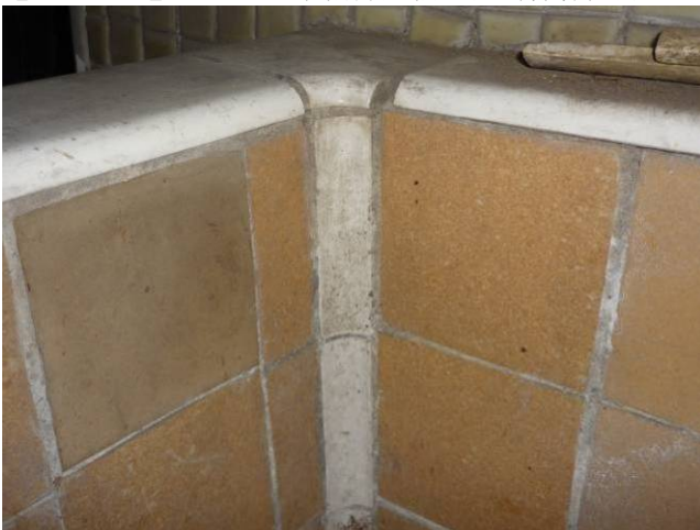
【圖 5-3-99】水槽壁面及轉角的白色收頭磁磚
