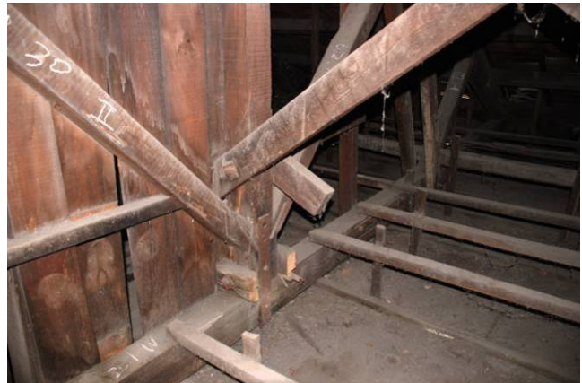
【圖 5-3-71】真束兩側分別留下機具及手工工具的痕跡 【圖 5-3-72】真束兩側的夾枋被鋸斷
