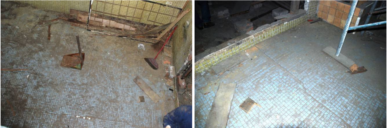
【圖 5-3-11】遠觀可見地坪馬賽克施作時以較大面積的矩陣成組鋪設
