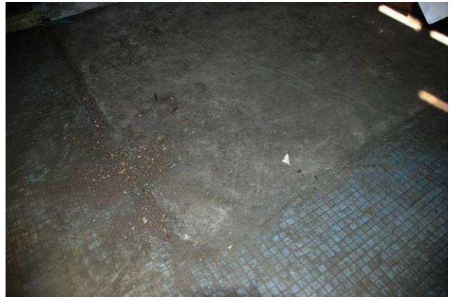
【圖 5-3-8】浴室鋪馬賽克地坪，浴池痕跡仍保留
