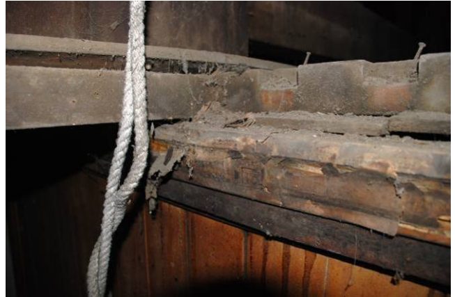
【圖 5-3-78】太子樓處的天花構造
