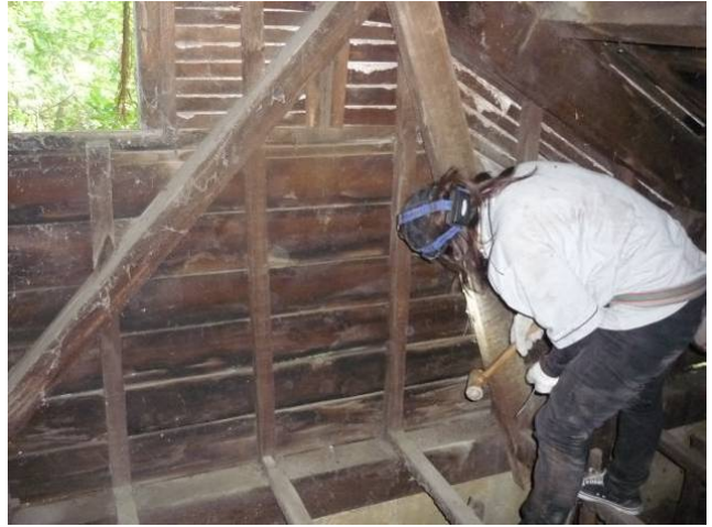
【圖 5-3-23】山牆部分由雨淋板與桷料、木摺壁構成
