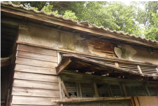
【圖 5-3-32】上端的牆體為木摺壁構造
