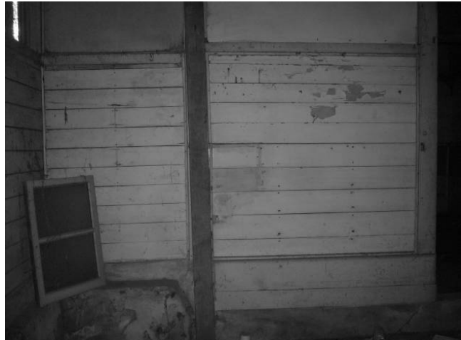
【圖 5-3-27】更衣場與浴室間隔牆，腰壁為羽目板張
