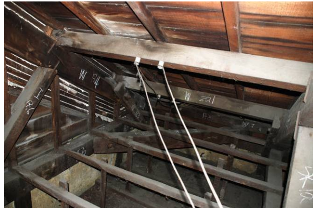
【圖 5-3-47】末端及中間均設有火打樑
