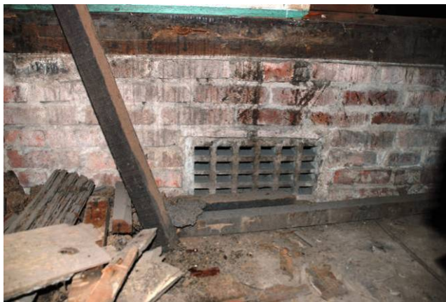
【圖 5-3-19】男女更衣室間牆基的通氣孔為水泥製成品
