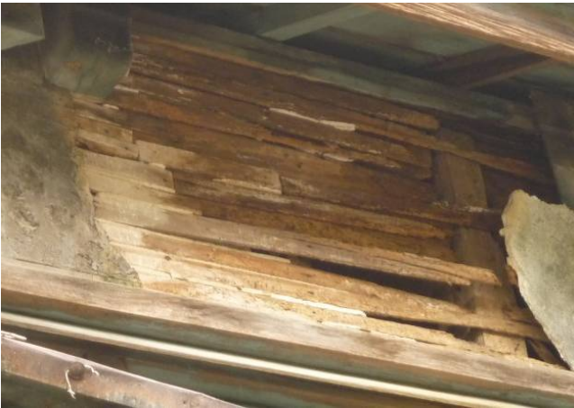
【圖 5-3-24】山牆木摺壁構造
