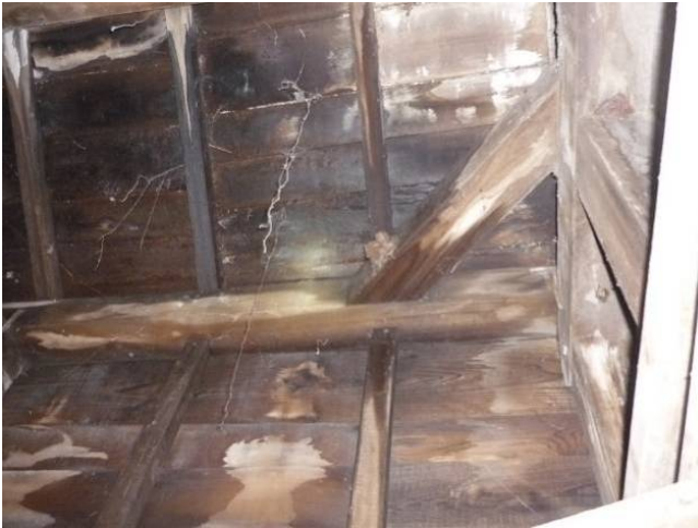
【圖 5-3-40】鍋爐場外牆雨淋板與桷料構造
