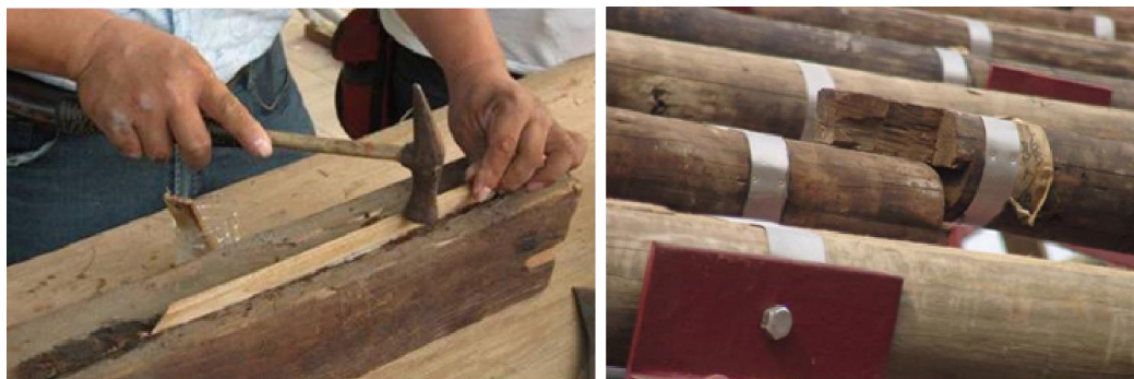
圖6-8木構件包覆鐵片（右）以及縫隙填補同材質木料
