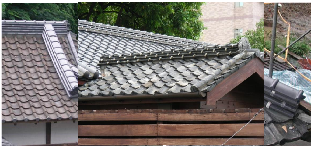
圖6-4日式建築舊瓦重鋪與新瓦集中鋪設
