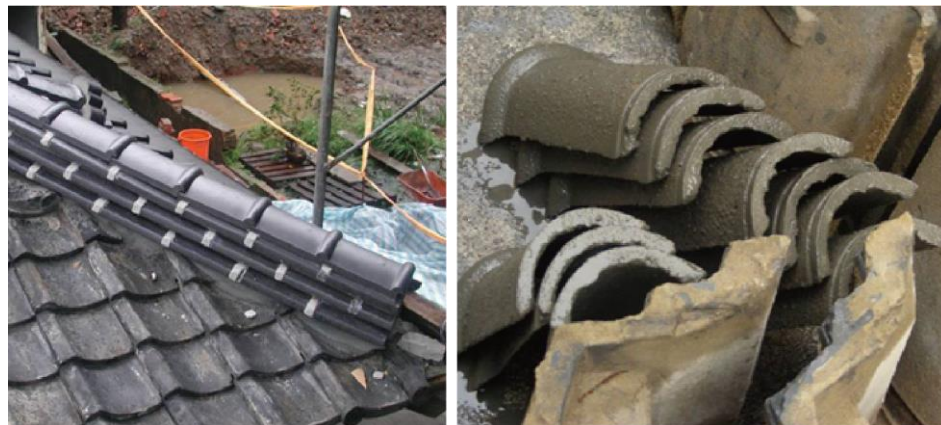
圖6-5日式建築舊瓦表面塗覆水泥砂漿
