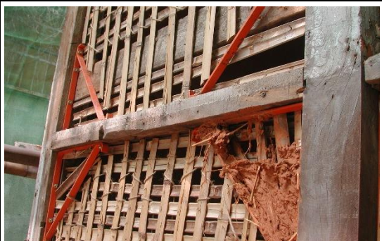
照6-7 木柱與貫木節點以鐵件補強
