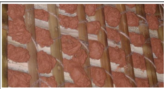
照6-5 編竹夾泥牆底層泥料塗覆
