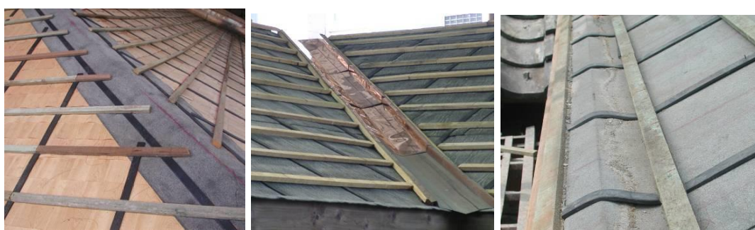
圖6-7屋頂新鋪防水毯並增設洩水條 (需注意避免在廣小舞部位產生凹槽)
