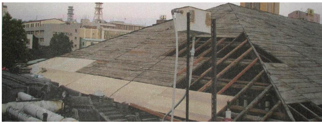
圖 6-6 新舊屋面板集中鋪設
