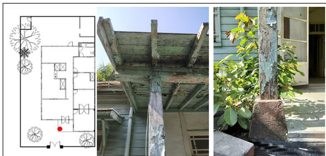
照4-1 簷（軒）木造屋頂稍有破損、支撐柱彎曲、劣化且油漆剝落
