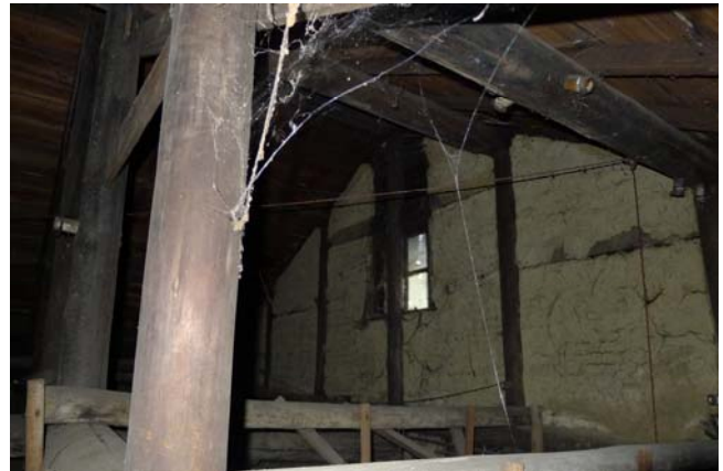
【圖 0-20】13 號之山牆壁灰泥剝落，真壁構造顯露
