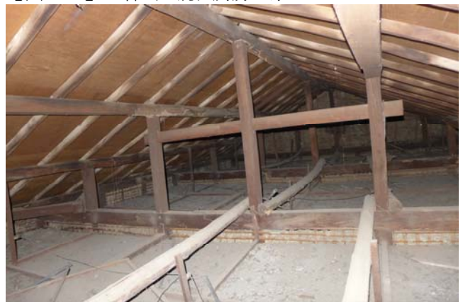
【圖 0-72】J 棟屋架採「和小屋」式，但跨距較 I 棟小
