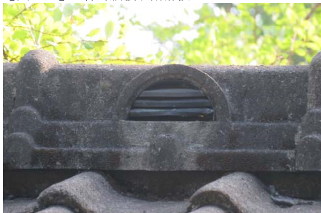
【圖 0-54】G 棟屋頂瓦脊棟瓦留設有通風口
