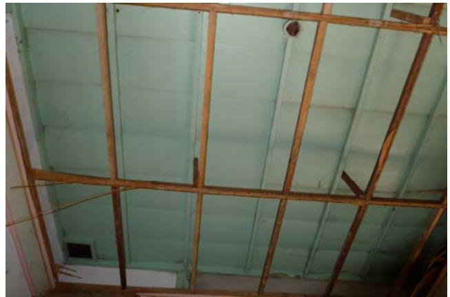
【圖 0-12】A 棟（4 號）天井板與通氣孔保存良好
