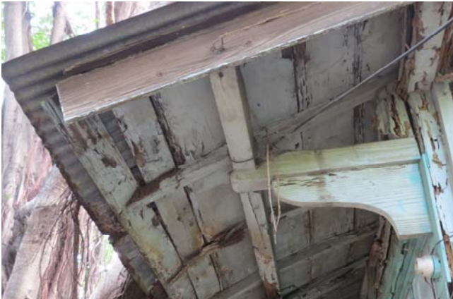
【圖 0-39】E 棟入口雨遮已改鐵皮浪瓦
