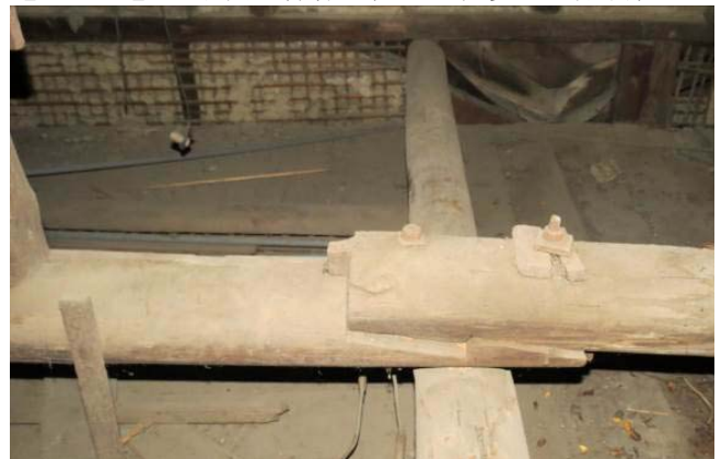
【圖 0-30】大樑木料以長斷面接榫，並以螺栓固定
