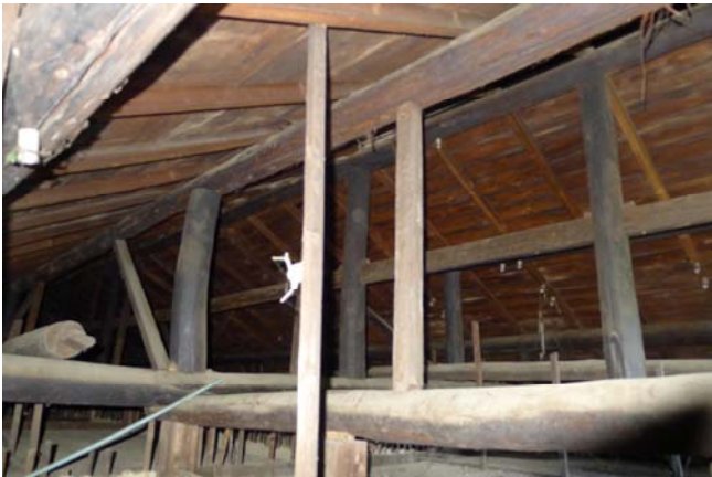
【圖 0-47】F 棟屋架束之間以貫木串連各組屋架
