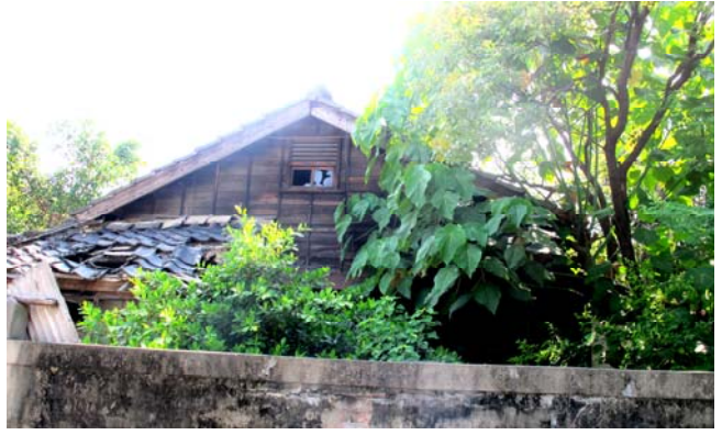
【圖 0-42】F 棟（1 號）山牆的舊有雨淋板與通氣窗
