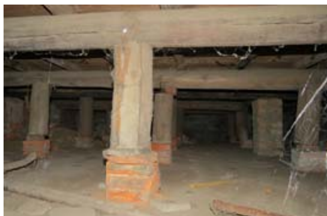
【圖 0-50】G 棟床架束石以二塊磚（1B）、四層拼接而成
