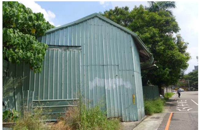
【圖 0-76】K 棟（8 號）側牆暫以鐵皮浪板保護之
