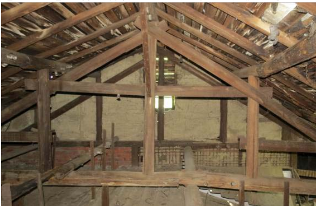
【圖 0-29】採傳統日式和小屋組之屋架型式
