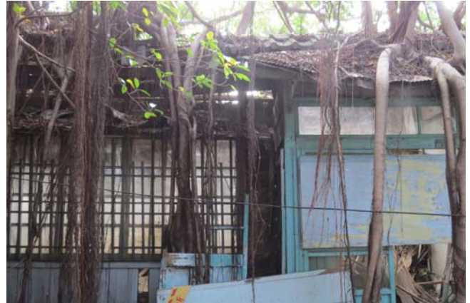
【圖 0-34】E 棟前院榕樹生長旺盛破壞建築物
