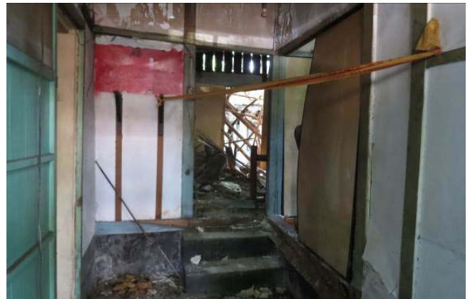
【圖 0-28】21 號內牆保存不佳，立柱多已蛀蝕腐朽
