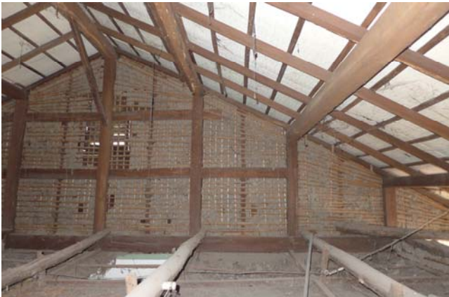
【圖 0-79】K 棟山牆為編竹夾泥牆構造
