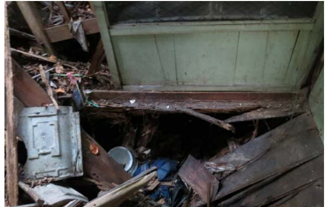
【圖 0-38】E 棟床組床板多已塌陷
