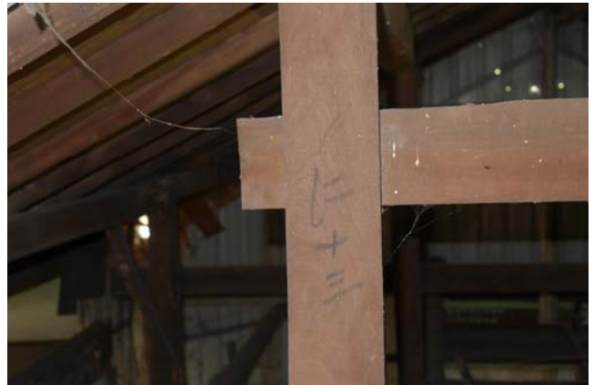
【圖 0-80】K 棟木屋架上的編號系統仍使用日文字
