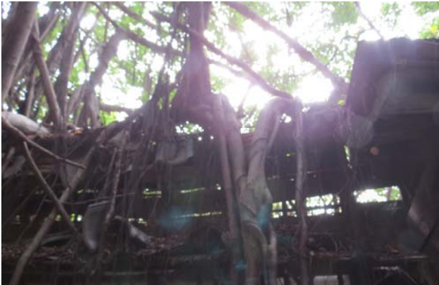
【圖 0-37】E 棟屋頂及屋架均已嚴重破壞
