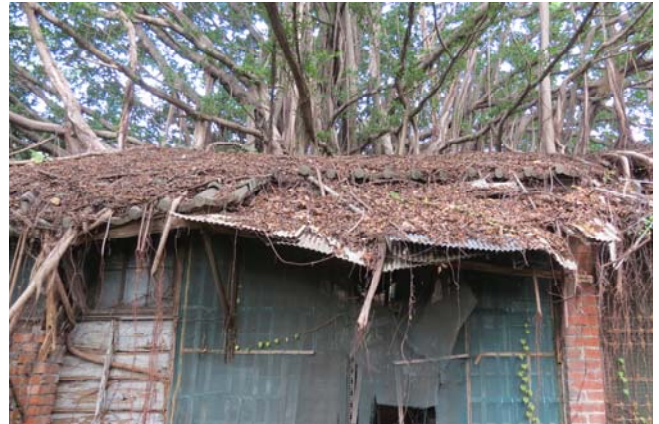
【圖 0-40】後院改為磚造，部分牆體保留雨淋板樣式
