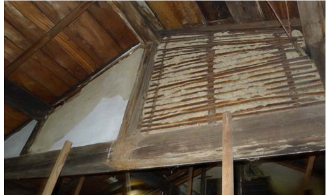
【圖 0-14】附屬空間山牆壁灰泥剝落，真壁構造顯露
