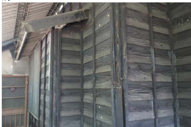
【圖 0-52】G 棟外牆覆以雨淋板
