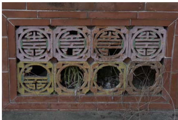
照片 3-2-16：基礎換氣開口近貌（本研究攝）
