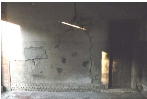
照片 3-2-19：門廳隔斷牆卵石基礎（本研究攝）
