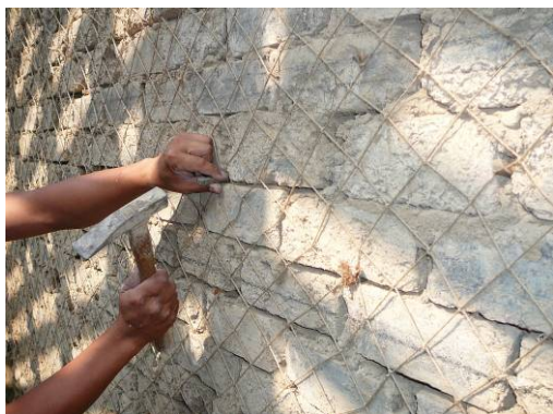
照片 6-1-3：土埆牆砌築後施作竹釘麻網
