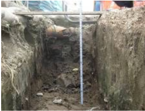
照片 6-1-9：基礎開挖 90cm 後深度量測
