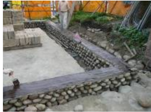
照片 6-1-16：基礎上方塗刷 RA 防水層
