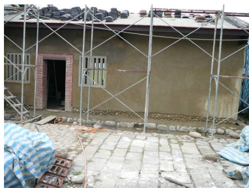
照片 6-1-6：外牆麻絨灰漿施作完成
