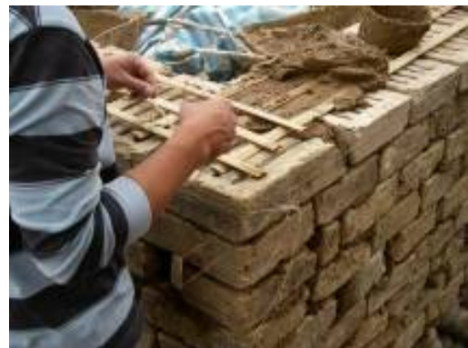
照片 6-1-18：每三層磚材間加設竹條補強
