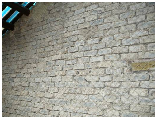
照片 6-1-4：土埆牆砌築完成
