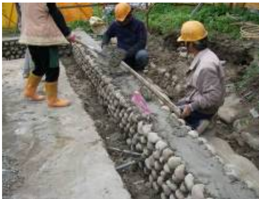
照片 6-1-13：基礎上方水泥砂漿整平
