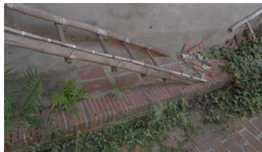
照片 5-1-4：左護龍後方排水溝阻塞（本研究攝）
