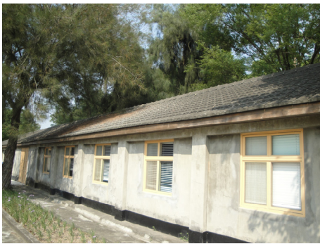
【照片 7-1】長向牆體具多開口部，牆體上緣有鋼筋混凝土樑。
