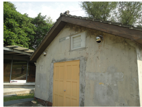
【照片 7-2】短向牆體上部山牆與山牆底部水平裂損。
