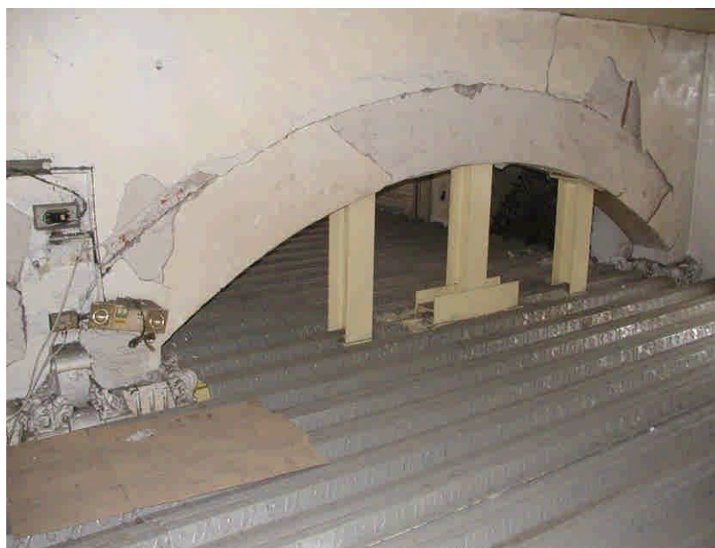
照片 1-3 921 集集地震後大廳上方增設之防護鋼板[3]
