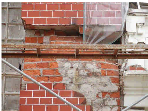
照片 1-1 地震後承重磚牆嚴重錯裂[3]
