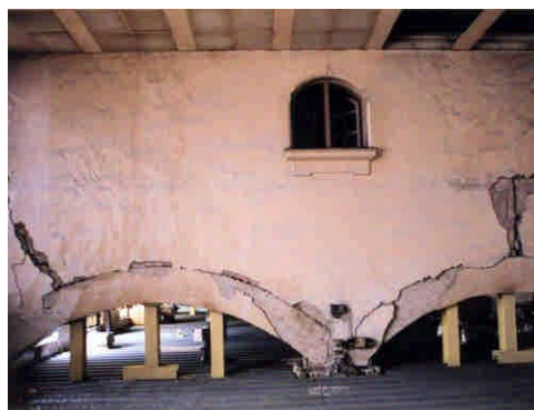
照片 1-2 拱樑及柱頭接續面錯開[3]
