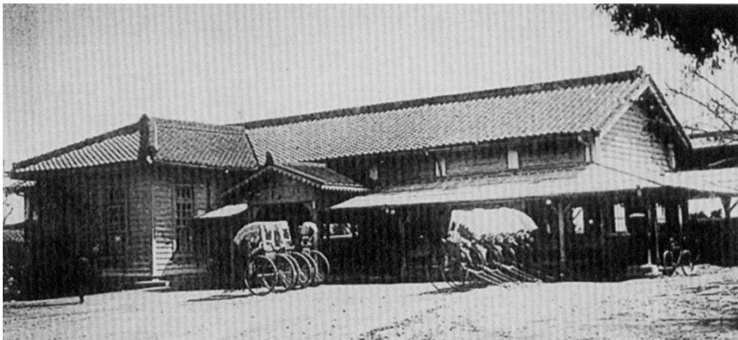
照片 3-1-3 第一代台中火車站(台中停車場)候車室入口處增設之車寄 資料來源：《台中拓殖畫帖》
