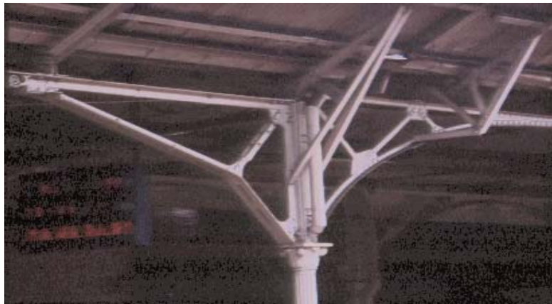
照片 3-3-5 月台鐵骨造雨庇及預鑄構架
