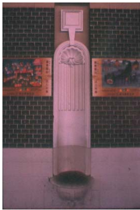
照片 3-3-4 大廳入口外側水泥內凹壁龕
