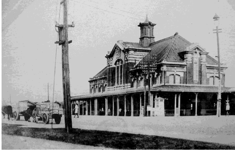
照片 3-3-1 第二代台中火車站外觀 資料來源：明信片，中原大學黃俊銘 研究室藏
