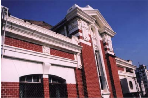
照片 3-4-6 外牆立面處理及材料
