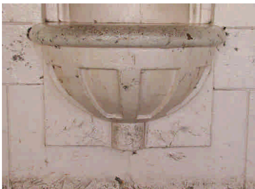
照片 3-5-1 騎樓外牆壁龕外表為油漆覆蓋情形[3]
