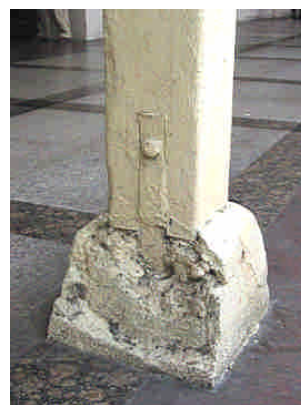
照片 3-7-2 土庇構架鬆脫情形[3]
