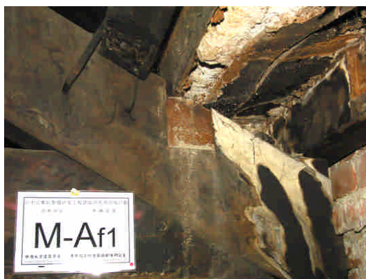
照片 3-7-1 屋架腐蝕情形[3]
