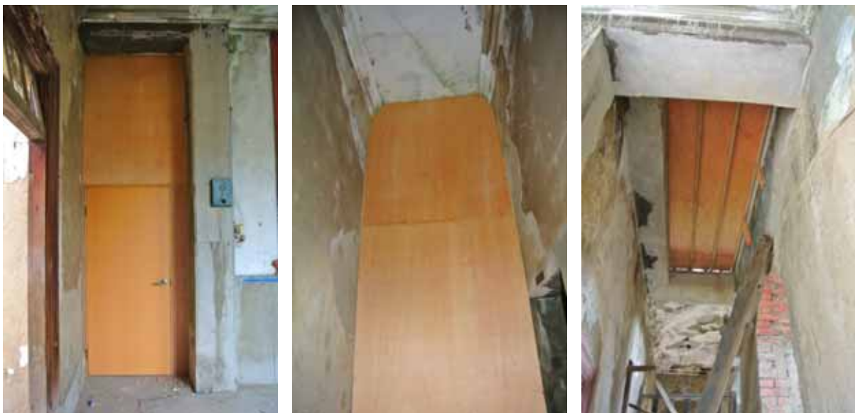
圖1-12 右側梯間前後側封閉、左側梯間樓版開口處封閉
