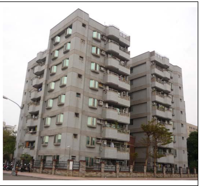
【圖2-2-19】位於三民路一段的「臺灣台中檢監所宿舍」。
