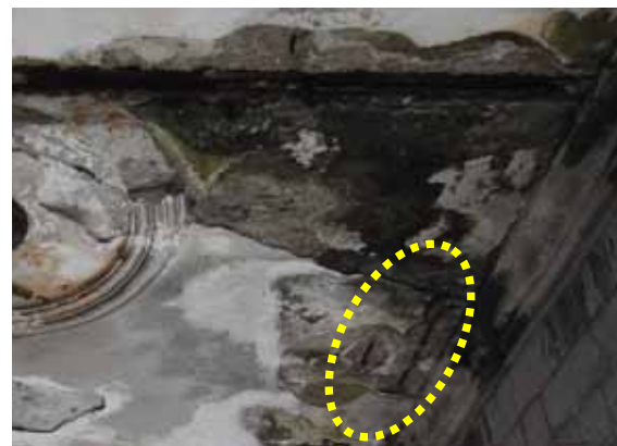
(b) 垂直於 I 型鋼樑方向之鋼筋
