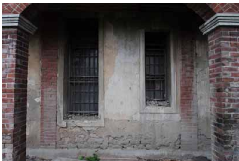
(a) 磚柱土埆磚牆外觀
